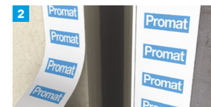
Jeśli to konieczne, zasłonić taśmą obszar roboczy na ścianie lub podłodze.
