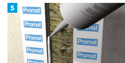
Zapewnić dobrą przyczepność podłoża pod pierwszą warstwę masy uszczelniającej.
