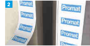
2 Jeśli to konieczne, zasłonić taśmą obszar roboczy na ścianie lub podłodze.
