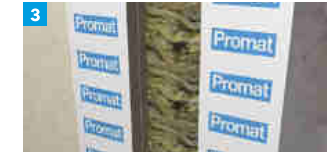
3 Wypełnić szczelinę materiałem wypełniającym (niepalnym lub palnym).
