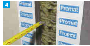
4 Zmierzyć odpowiednią głębokość.
