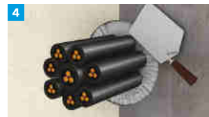
4 Wygładzić powierzchnię masy uszczelniającej pędzlem lub packą zwilżoną wodą zanim utworzy się sztywna powłoka.
