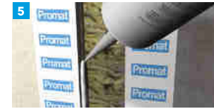
5 Zapewnić dobrą przyczepność podłoża pod pierwszą warstwę masy uszczelniającej.
