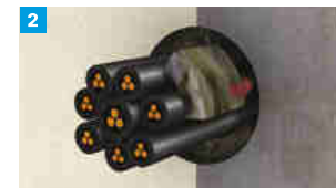
2 Szczelnie wypełnić wełną mineralną.
