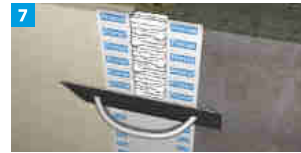
7 Wygładzić powierzchnię masy uszczelniającej pędzlem lub packą zwilżoną wodą.
