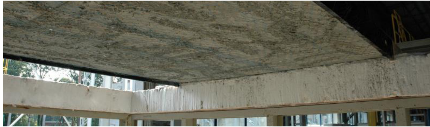
Przykładowa powierzchnia betonu z warstwą wiążącą key coat
