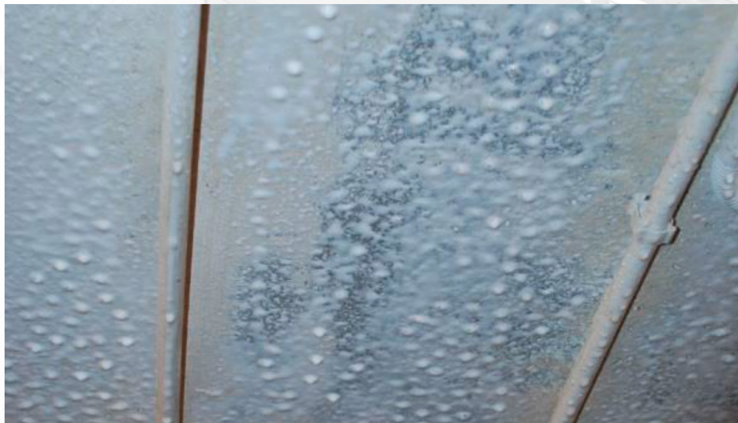
Przykład gruntowania powierzchni przed aplikacją PROMASPRAY®F250
