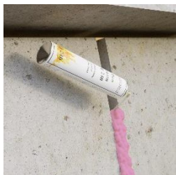
Wypełnij szczelinę pianą Piro Foam PF 240 pionową szczelinę dylatacyjną
