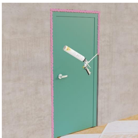
Wypełnij przestrzeń między ościeżnicą a ścianą za pomocą pianki Piro Foam PF 240
