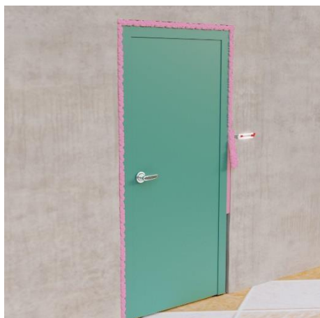
Obetnij nożykiem wystające pozostałości pianki Piro Foam PF 240
